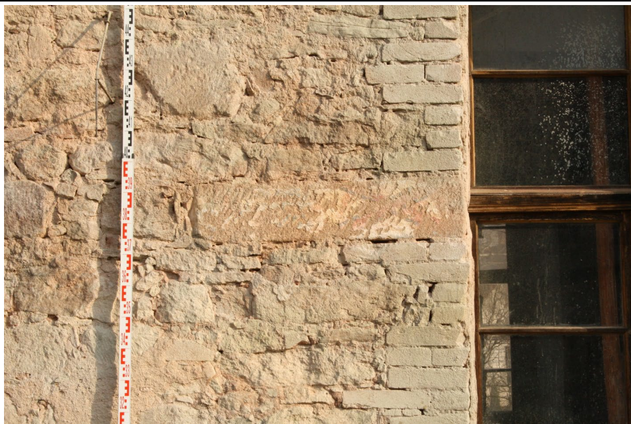
Detail středověkého kvádrů s okosenou hranou a polychromií, který byl druhotně osazen do západní špalety západního okenního otvoru jižní strany lodi. Foto: Jaroslav Skopec 2014.
