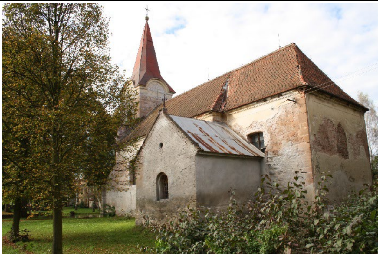
Celkový pohled od jihovýchodu. Foto: Jaroslav Skopec 2014.
