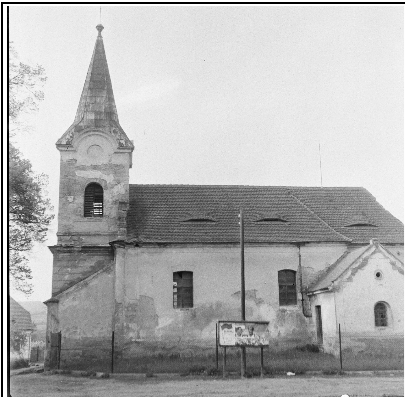
Celkový pohled od jihu. Foto: 1963, sbírka negativů NPÚ ÚOP v Ústí n. L., sig. 8937.
