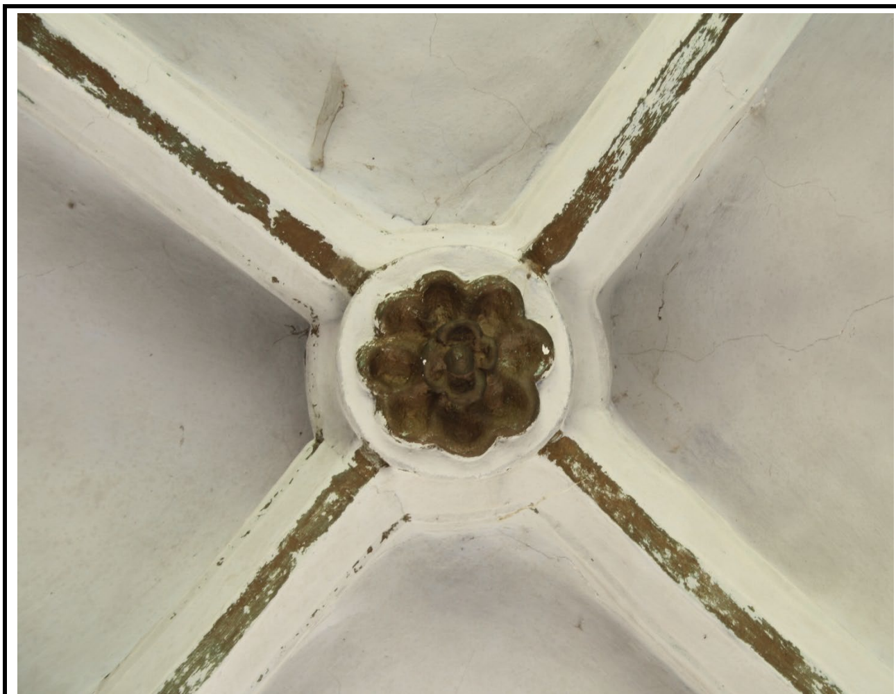
Detail svorníku klenby presbytáře. Foto: Jaroslav Skopec 2014.
