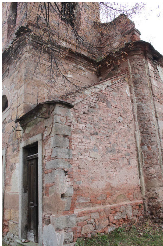
Schodišťový přístavek v pohledu od jihozápadu. Foto: Tomáš Brož 2014.
