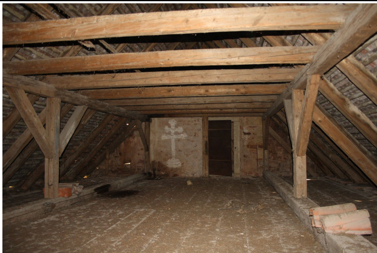
Pohled do krovu nad lodí směrem k západu. Foto: Jaroslav Skopec 2014.
