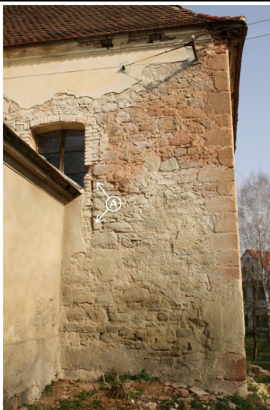
Pohled na východní polovinu jižního průčelí presbytáře. A – spára mezi cihelnou obezdívku stávajícího okenního otvoru a zalícovaným kamenným zdivem presbytáře, které naznačuje možnost existence středověkého okenního otvoru. Foto: Jaroslav Skopec 2014.
