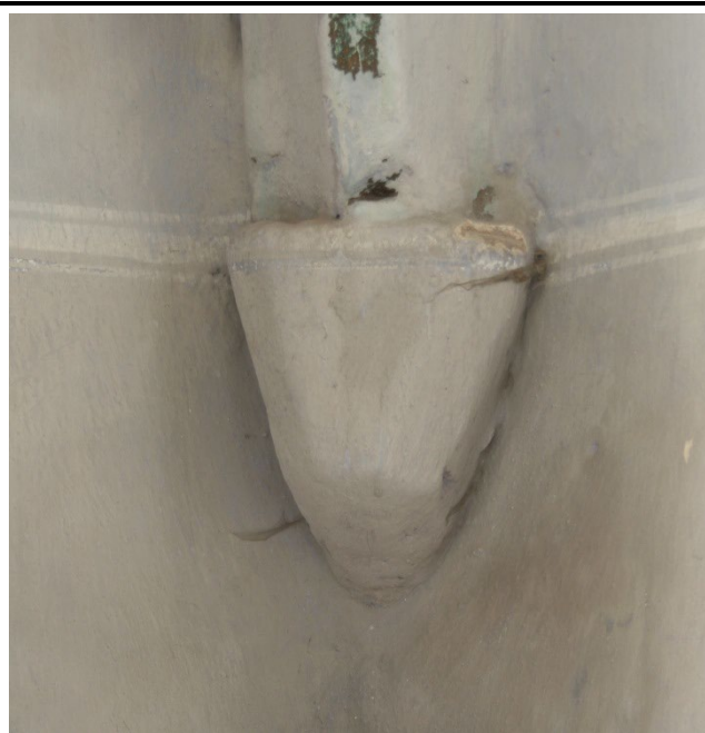
Detail jihovýchodní konzole klenby presbytáře. Foto: Jaroslav Skopec 2014.
