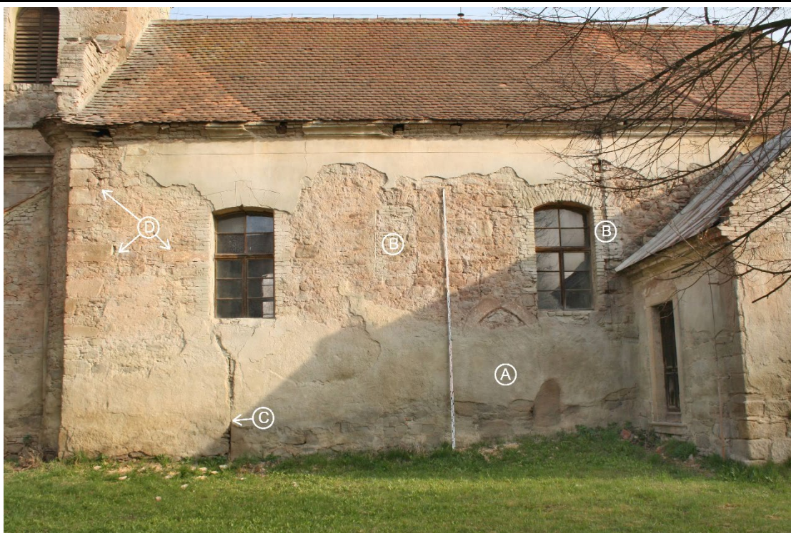
Čelní pohled na jižní průčelí lodi. A – středověký portál zazděný při rozšíření lodi roku 1788. B – dvojice středověkých okenních otvorů zazděných při rozšíření lodi a realizaci stávajících okenních otvorů roku 1788. C – vertikální spára určující původní délku středověké lodi s v patě dochovanými kvádry nárožního armování. D – středověké kvádry druhotně použité při prodloužení lodi v roce 1788. Foto: Jaroslav Skopec 2014.
