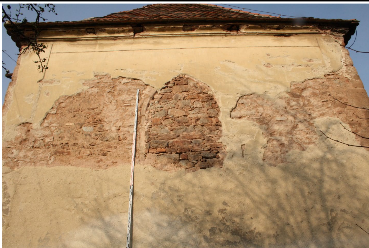
Pohled na východní průčelí presbytáře se zalděným středověkým okenním otvorem. Foto: Jaroslav Skopec 2014.
